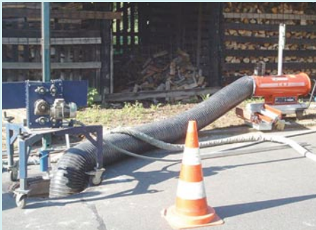
Trocknung eines Schachtes im Vorfeld einer Polyurethanbeschichtung
