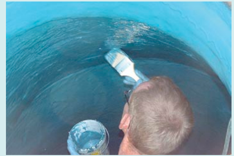
Nachbehandlung einer Polyurethanbeschichtung
