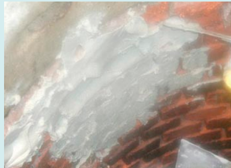
Vorbeschichtung einer Mauerwerkswandung mit starker Fugenkorrosion
