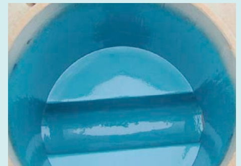
Einwandfreie Polyurethanbeschichtung auch bei hohem Feuchtegehalt des Untergrundes
