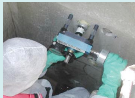
Mörtel: Haftzugprüfung an einer Beschichtung
