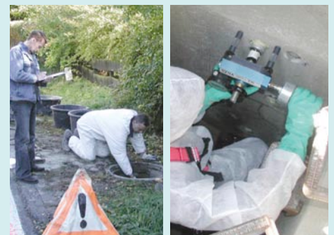
Polyurethanbeschichtung im Sprüh-Schleuderverfahren
