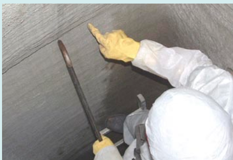
Eine detaillierte optische Inspektion leistet gute Dienste bei der Beurteilung der Qualität einer Beschichtung
