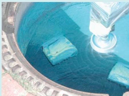
Polyurethanbeschichtung im Sprüh-Schleuderverfahren
