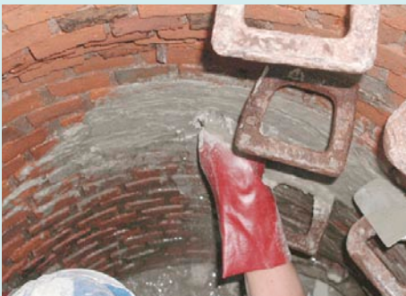
Abdichten eines Mauerwerksschachtes mit Stopfmörtel
