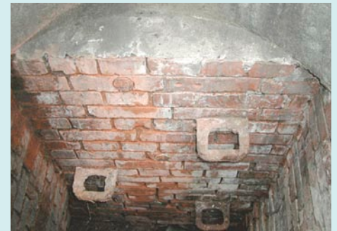
Übergangsbereich rechteckiger Mauerwerksschacht/runder Konus aus Beton mit waagerechten Versprünge in der Schachtwandung
