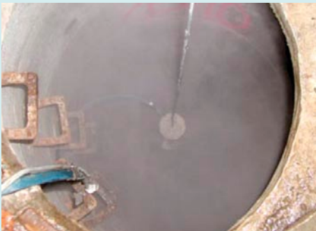
Wasserhochdruckreinigung einer Schachtwandung mit rotierender Reinigungsdüse
