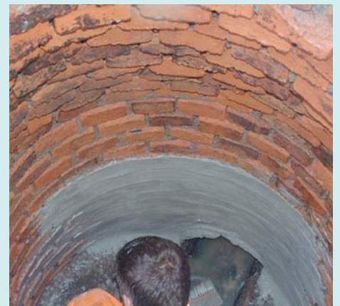
Auftrag des Mörtels auf „schmutzige“ Wandung
