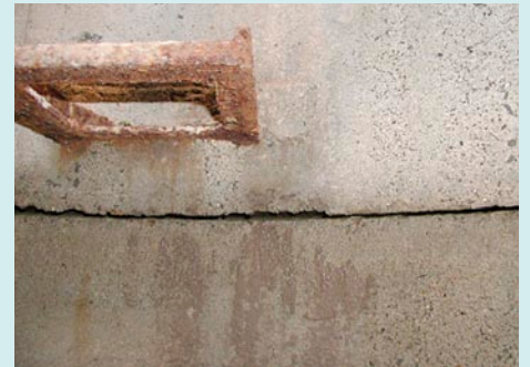
Schmutzrückstände auf der Wandung nach Reinigung
