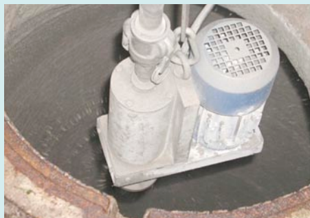
Mörtelbeschichtung im Anschleuderverfahren
