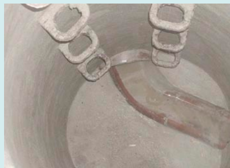
Komplett vorbeschichteter Mauerwerksschacht
